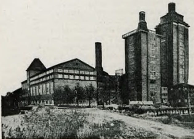
Rys. 1. Widok wielkich kotłów parowych w Państwowej Elektrowni w Västerås.
