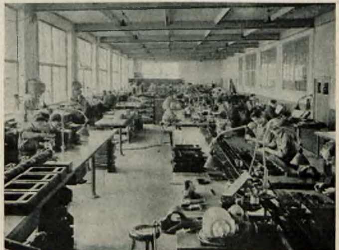
Rys. 12. Montaż przekładników w warsztatach Arvid.
