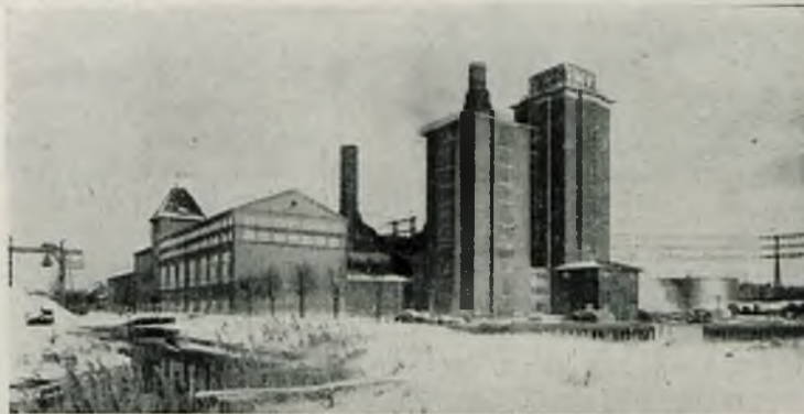
Rys. 9. Ogólny widok centrali parowej w Västerås.
