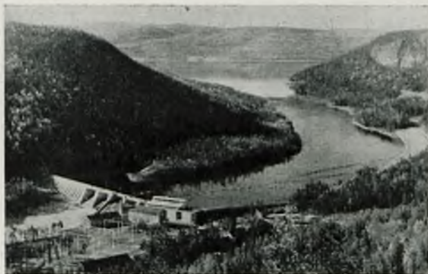
Rys. 2. Widok elektrowni wodnej Krångede Kraftverk .
