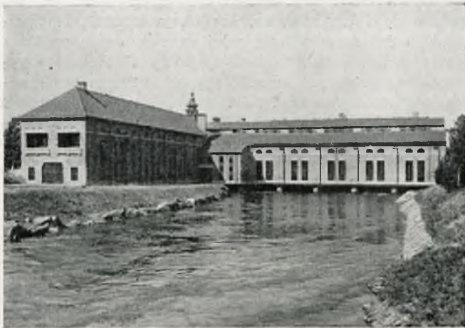
Rys. 5. Zakład wodno-elektryczny Untra na rzece Dalälven .
