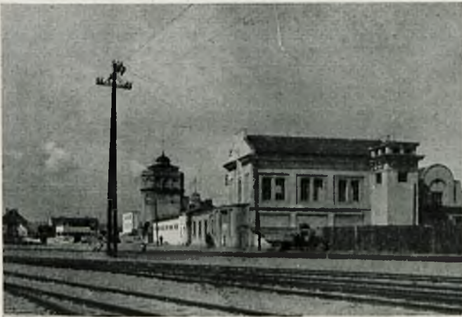
Rys. 2. Elektrownia Portowa i Stacja I Urzędu Morskiego w Gdyni.
