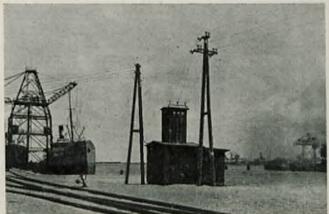
Rys. 4. Prowizoryczna stacja transformatorowa dla nabrzeża Holenderskiego, o mocy 520 kVA.
