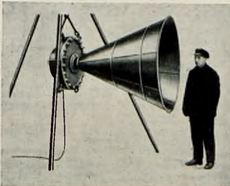
Rys. 4. Powietrzny nadajnik akustyczny o mocy ok. 2000 watów akustycznych.
