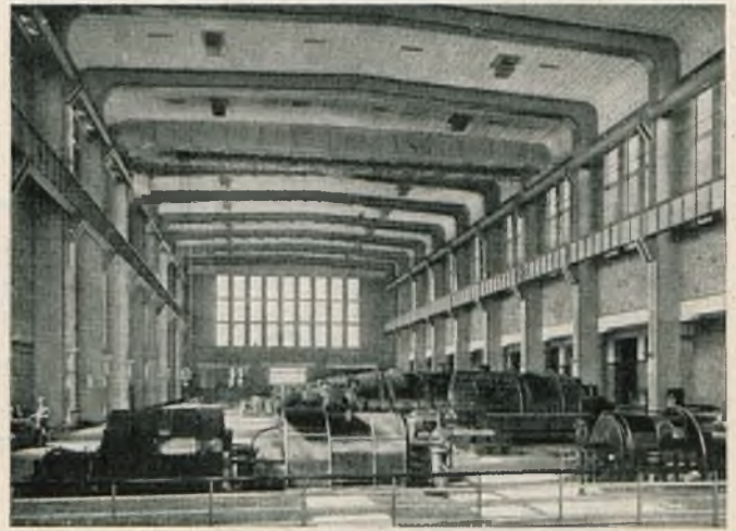
Rys. 3. Widok sali maszyn.
