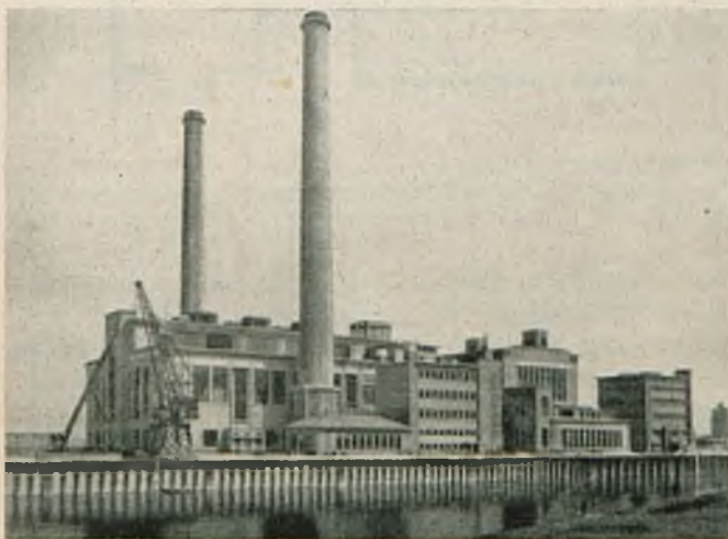
Rys. 2. Ogólny widok elektrowni Gelderland.
