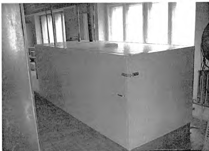
Rys. 8. Agregat sprężarkowy w obudowie dźwiękochłonnej
