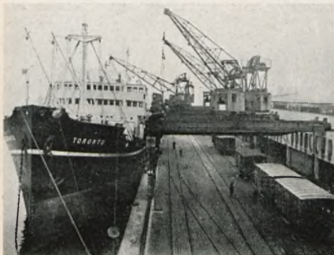
Przeładunek drobnicy dźwigami żorawowymi.
