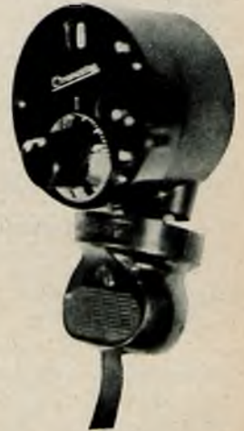
Rys. 35. Zegar do samoczynnego włączania prądu w grzejnikach o dowolnej (w zakresie 12 godz.) godzinie i minucie. Produkcja zagraniczna.
