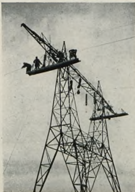
Rys. 15. Montaż przewodów.
