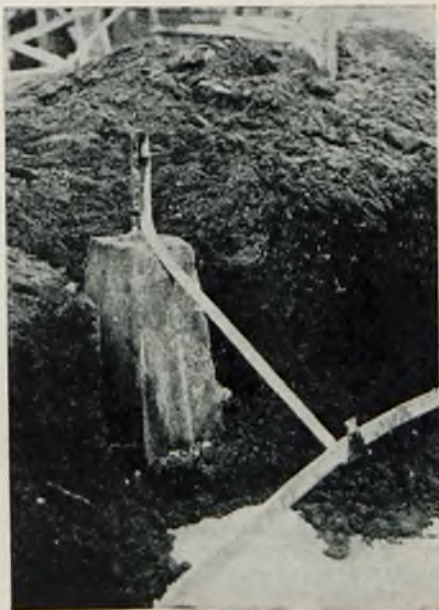
Rys. 27. Kontakt probierczy uziemiacza grupowego.
