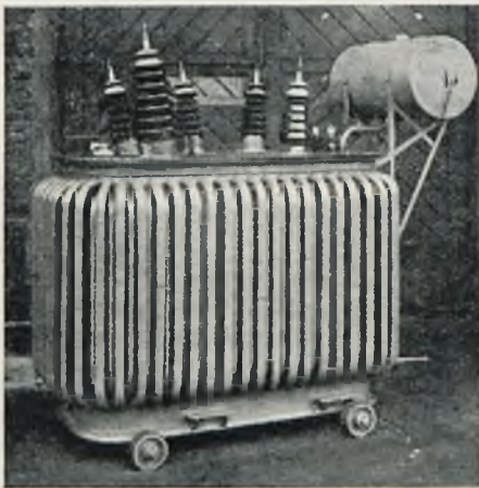
Rys. 4. Cewka gasikowa ziemna.
