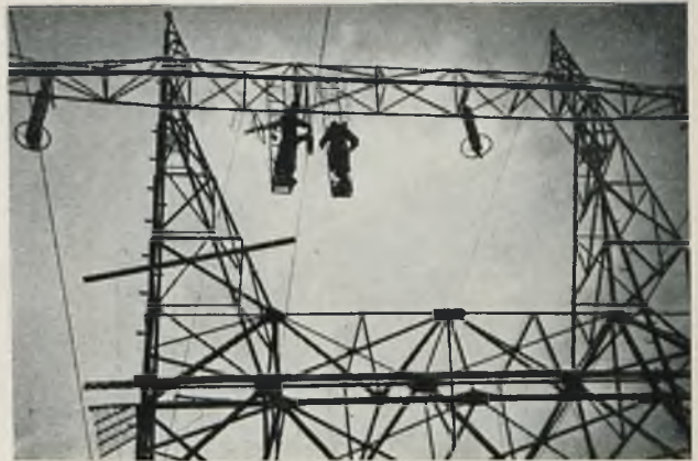
Rys. 16. Montaż przewodów.
