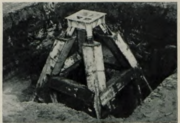
Rys. 18. Uzbrojona i zabetonowana wieżycy fundamentowa.
