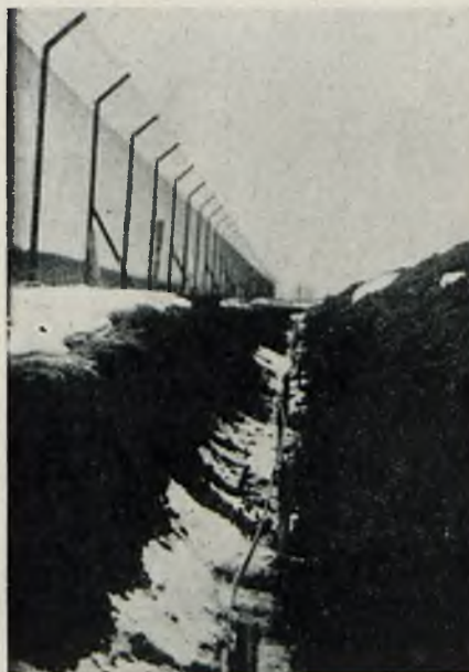
Rys. 26. Fragment uziemiacza punktu zerowego — przed zasypaniem ziemią.
