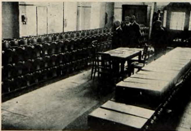
Rys. 20. Partia grzejników elektrycznych.
