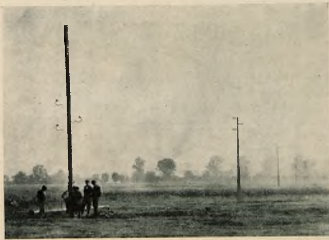
Rys. 1. Rozbity słup linii 6 kV.
