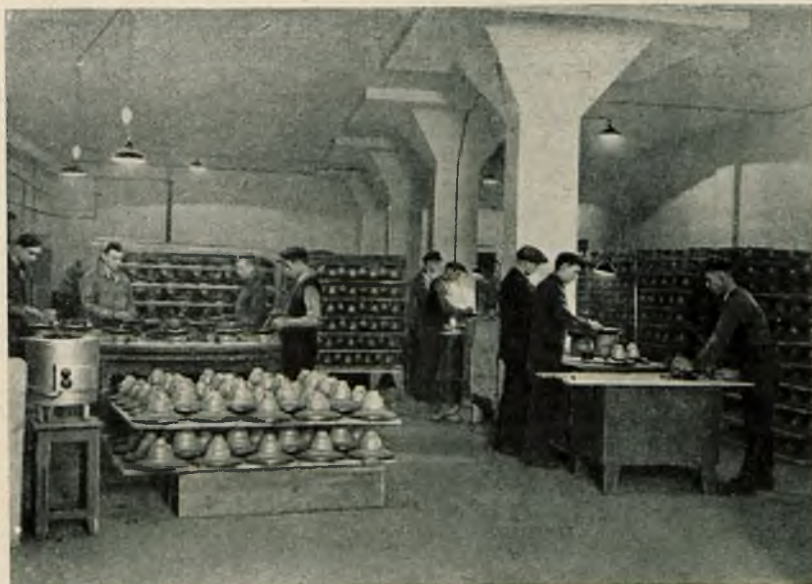
Rys. 2. Montaż izolatorów wiszących w fabryce K. Szpotański i S-ka.
