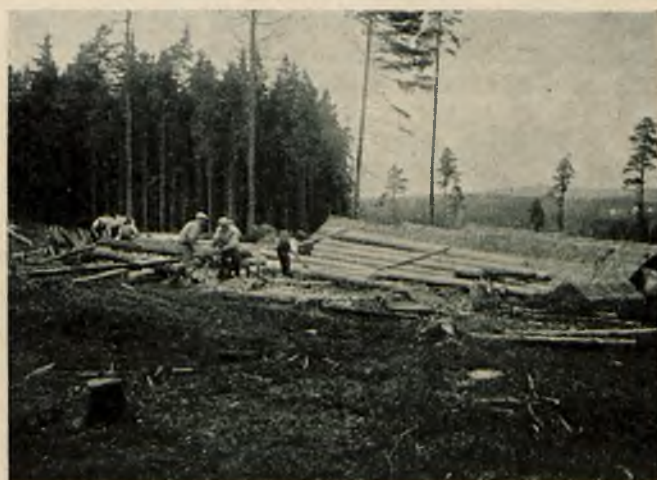
Rys. 8. Nasycanie metodą „Osmoza”
