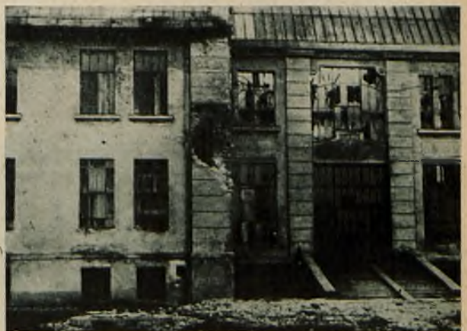
Rys. 7. Uszkodzony budynek elektrowni na Persenkówce w r. 1919.
