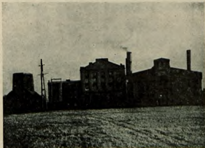
Ogólny widok elektrowni.
