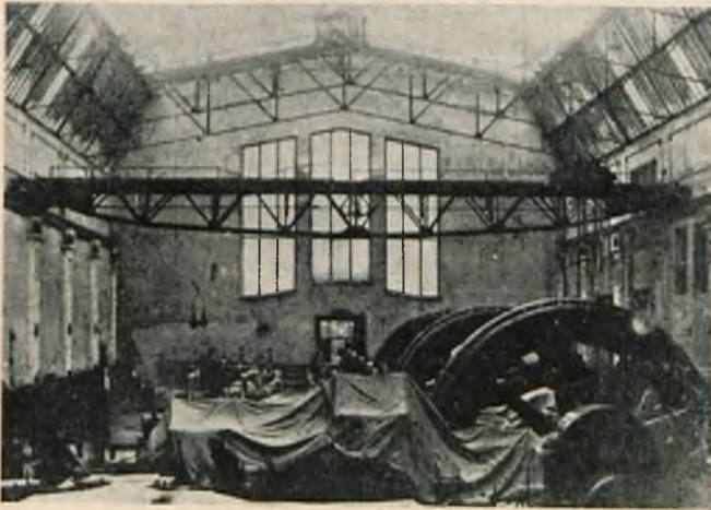
Rys. 3. Zniszczona sala maszyn elektrowni na Persenkówce w r. 1919.
