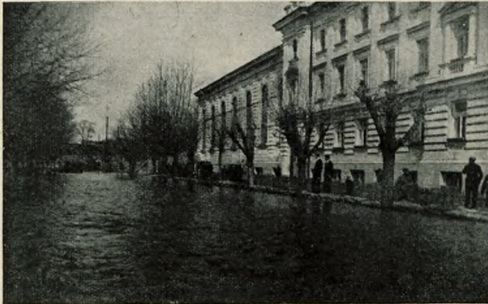
Gmach elektrowni. (zdjęcie z czasów powodzi z 1931 r.)
