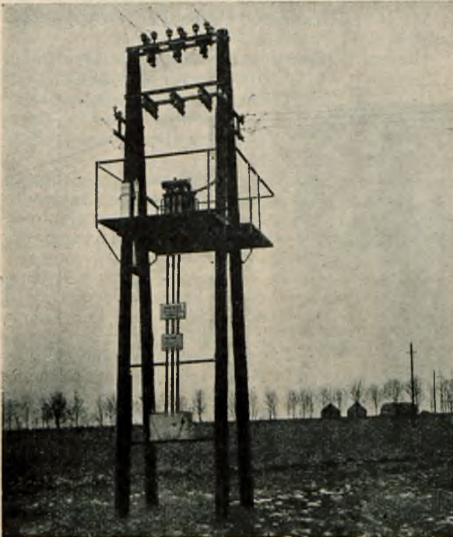
Stacja transformacyjna 6000/380/220 V o mocy 30 kVA, zasilająca cukrownię Ostrowy w pow. Kutnowskim,
