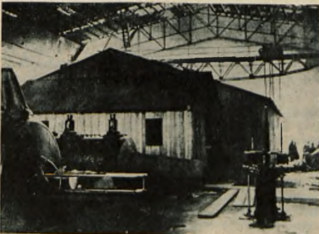
Rys. 4. Ochrona maszyn w zniszczonej sali maszyn na Persenkówce w r. 1919.
