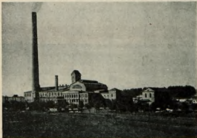
Ogólny widok elektrowni.
