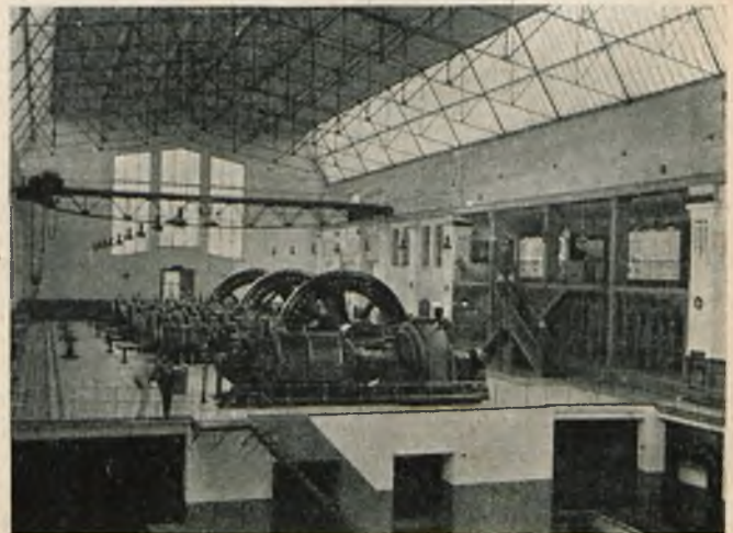
Rys. 2. Sala maszyn na Persenkówce.
