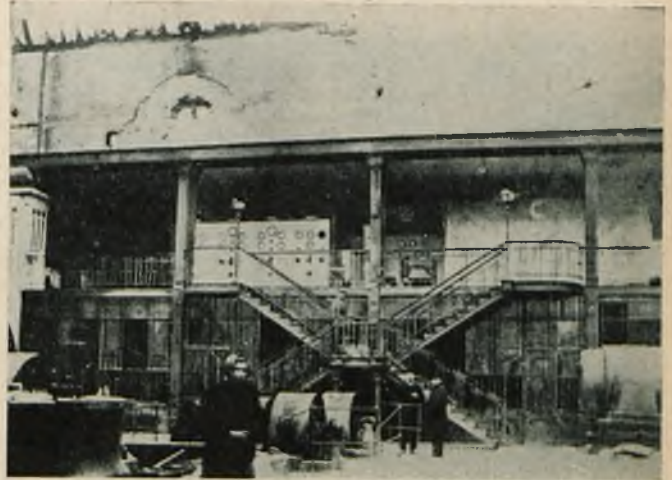
Rys. 5. Uszkodzona rozdzielnia elektrowni na Persenkówce w r. 1919.
