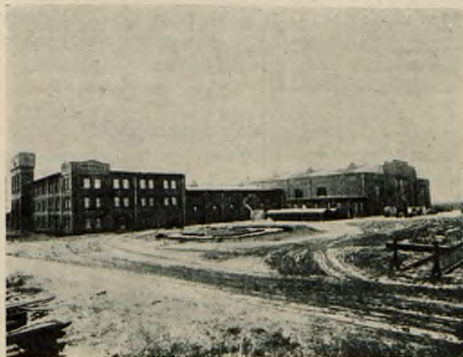
Ogólny widok fabryki „Kabel Polski” S. A. w Bydgoszczy.
