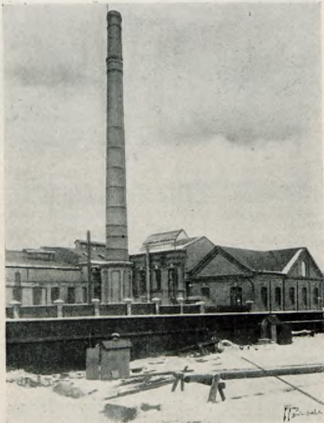
Ogólny widok elektrowni.
