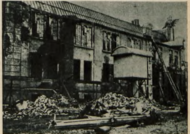
Rys. 6. Widok uszkodzonego budynku elektrowni na Persenkówce w r. 1919.
