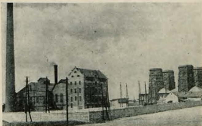
Ogólny widok elektrowni.
