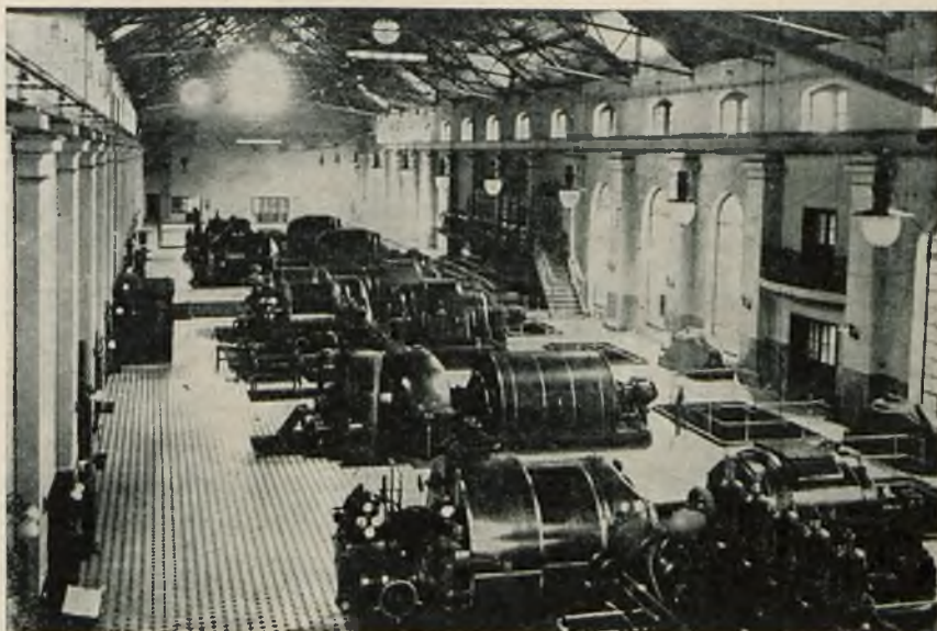
Widok sali maszyn wzdłuż osi.
