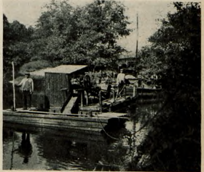
Rys 6. Bagrowanie zapomocą elektrycznego motoru.
