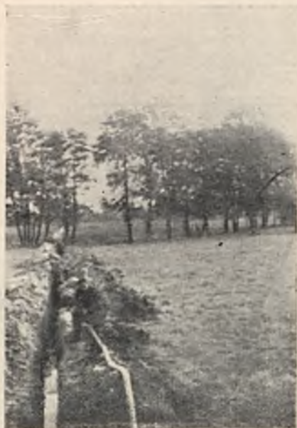
RYŚ. 3. RÓW KABLOWY W POLU NA TRASIE PRZYSZŁEJ SZOSY.
