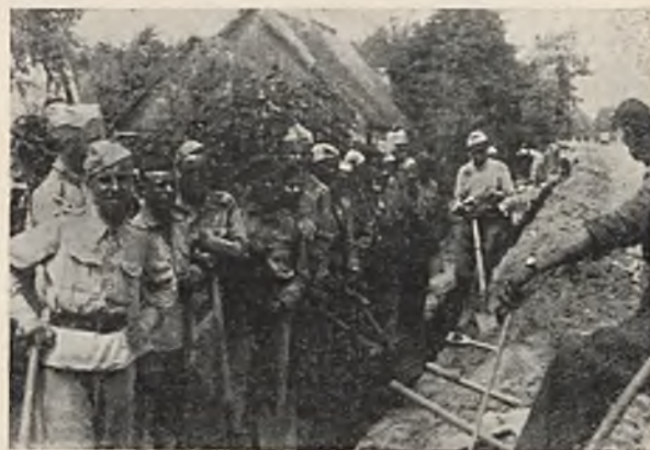
RYC. 2. NAD PRZYGOTOWANYM ROWEM KABLWYM.
