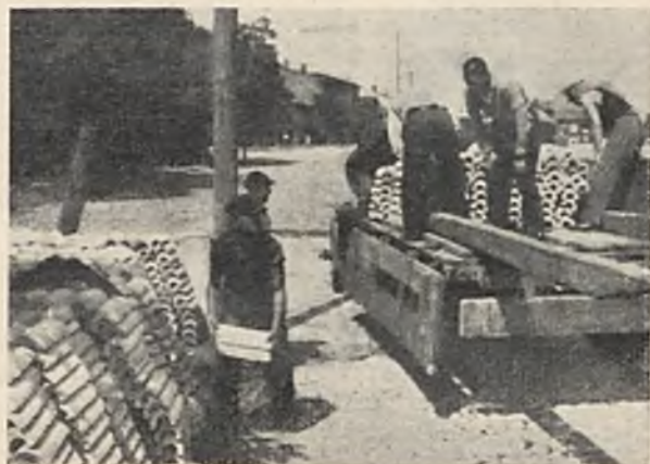
RYŚ. 5. TRANSPORT PŁYTEK BETONOWYCH.
