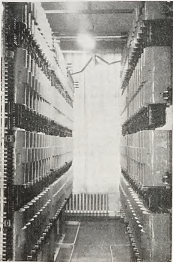
RYS. 12. STOJAKI WYBIERAKÓW LINIOWYCH AUTOMATU MIĘDZYMIASTOWEGO.
