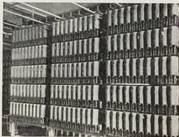
RYS. 9. STOJAKI WYBIERAKÓW GRUPOWYCH AUTOMATU MIĘDZYMIASTOWEGO.
