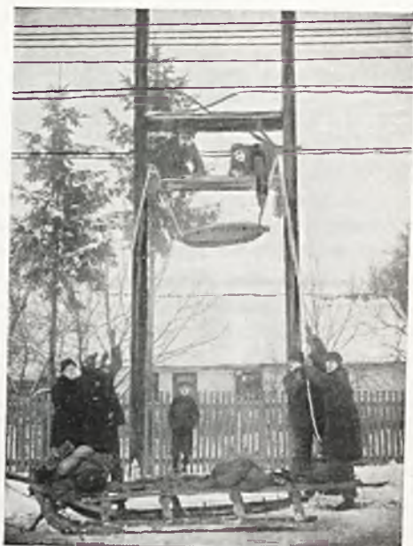
RYS. 1. WCIĄGANIE SKRZYNI Z CEWKAMI PUPINA NA SŁOPY.
