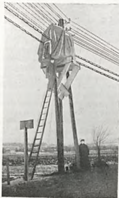
RYS. 3. NAMIOT ZMONTOWANY NA RUSZTOWANIU.
