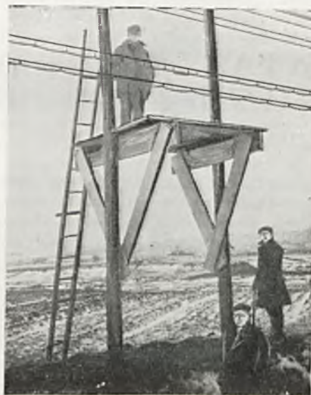
RYS. 4. ZŁĄCZE NA KABLU.
