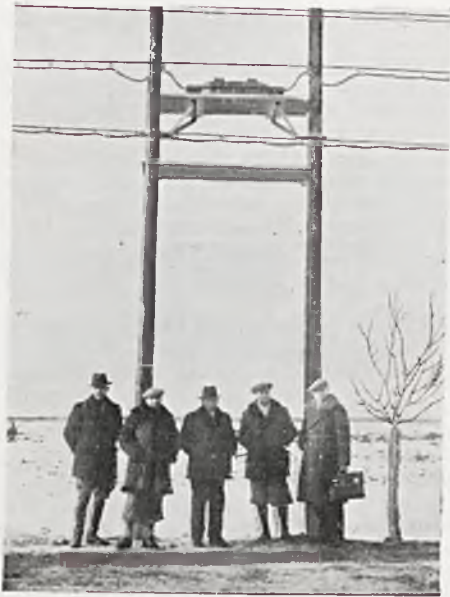
RYC. 5. ZMONTOWANA SKRZYŃKA Z CEWKAMI PUPINA.
