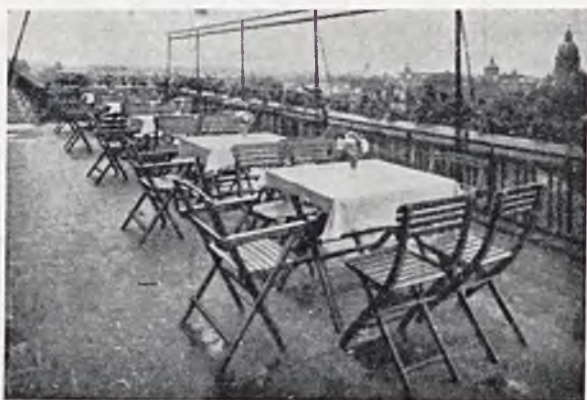
RYC. 2. TARAS BUDYNKU URZĘDU TELEGRAFICZNEGO W MANNHEIM.
