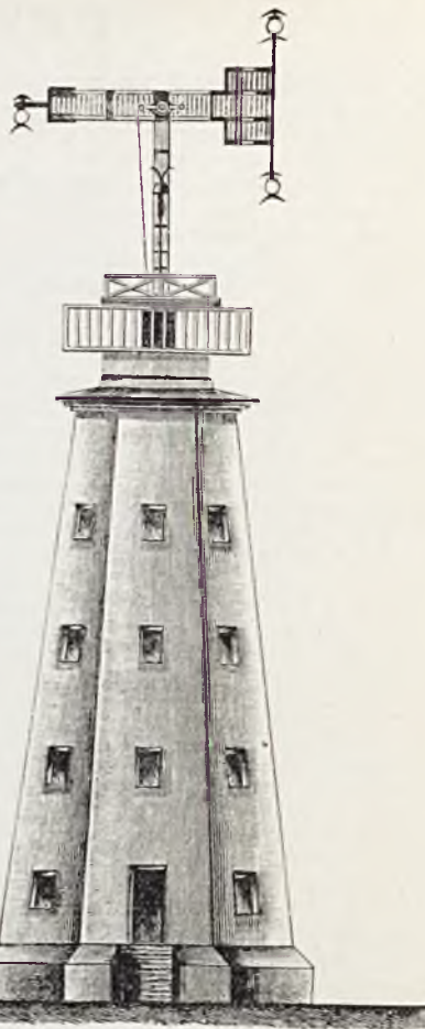
RYŚ. 2. WIEŻA TELEGRAFU OPTYCZNEGO SYSTEMU CHATEAU NA LINJI WARSZAWA—PETERSBURG.
