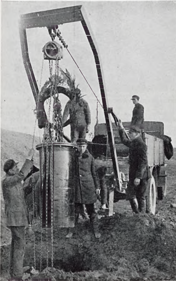
RYŚ. 5. OPUSZCZANIE SKRZYNI Z CEWKAMI PUPINA DO STUDNI.
