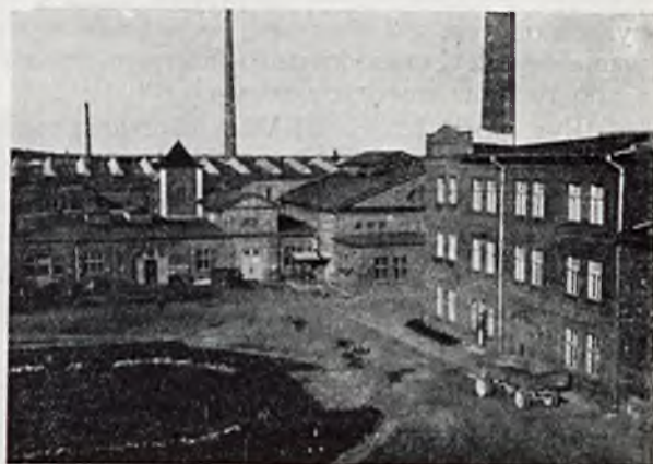
RYŚ. 1. OGÓLNY WIDOK FABRYKI „KABEL POLSKI” W BYDGOSZCZY.
