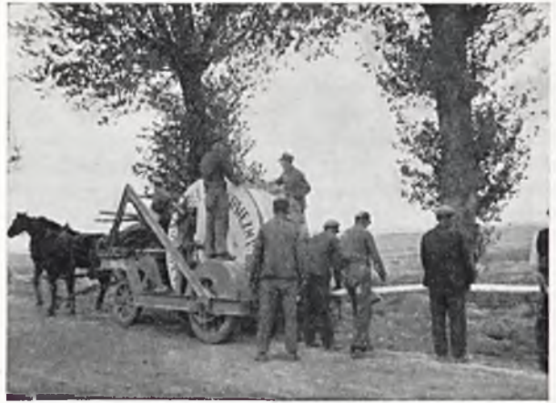
RYS. 3. UKŁADANIE KABLA.
