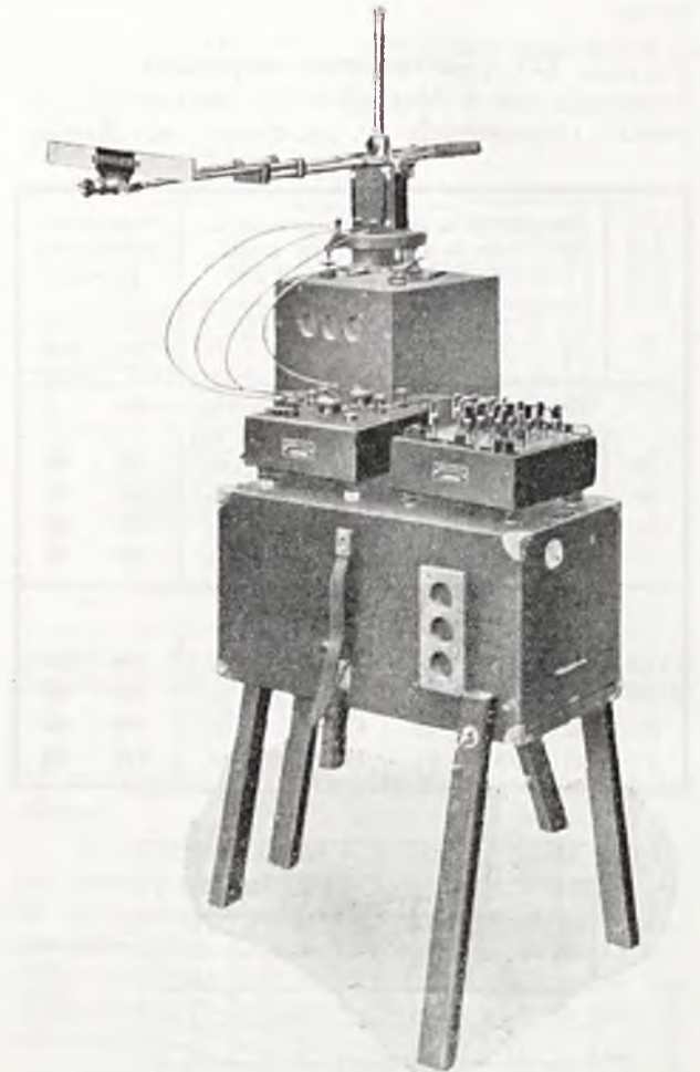
RYC. 12. ZESPÓŁ PRZEŃOSNY DO POMIARU IZOLACYJNOŚCI W WYKONANIU F. „SIEMENS”.
