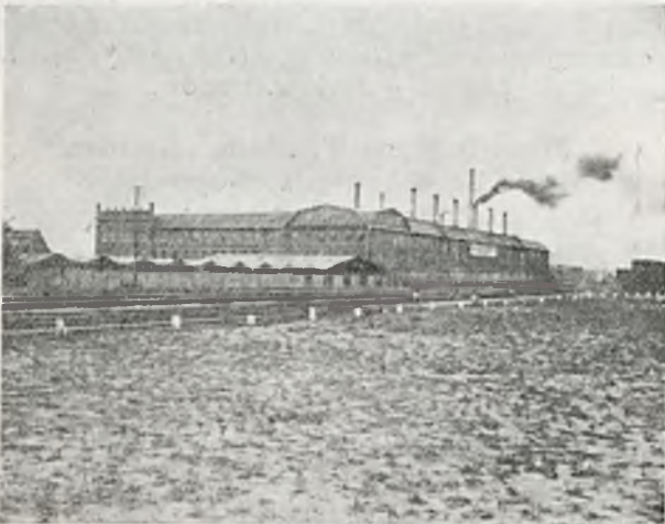
RYC. 13. FABRYKA PORCELANY W CHODZIEŻY.
