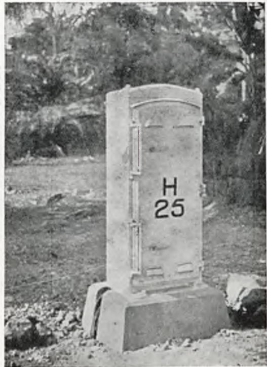
RYŚ. 42. WIDOK SZAFKI TOROWEJ MIESZCZĄCEJ PRZEKĄŻNIKA, TRANSFORMATORKI I URZĄDZENIA ZABEZPIECZAJĄCE.
