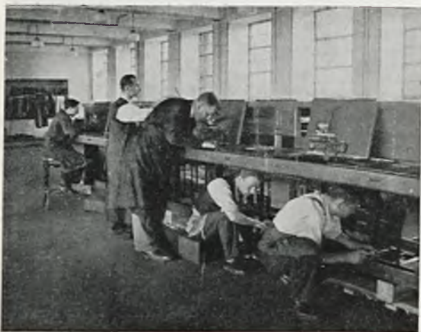
RYC. 3. MONTAŻ ŁĄCZNICZY TELEFONICZNEJ MIĘDZYMIASTOWEJ DLA KRAKOWA.
