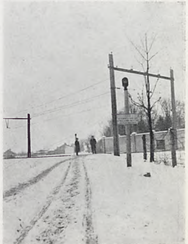
RYŚ. 11. OGÓLNY WIDOK URZĄDZEŃ SYGNALIZACYJNYCH PRZEJAZDU NA DWUTOROWYM ODCINKU.
