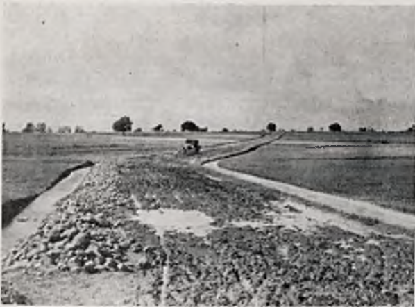
RYS. 1. DROGA ŁÓDŹ—PIOTRKÓW, NA KTÓREJ UKŁADANO KABEL PRZED WYBUDOWANIEM SZOSY.
