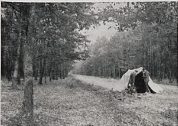
RYŚ. 4. POMIARY I ŁĄCZENIE ODCINKÓW KABLA POD MOSZCZENICĄ NA TRASIE ŁÓDŹ—PIOTRKÓW.
