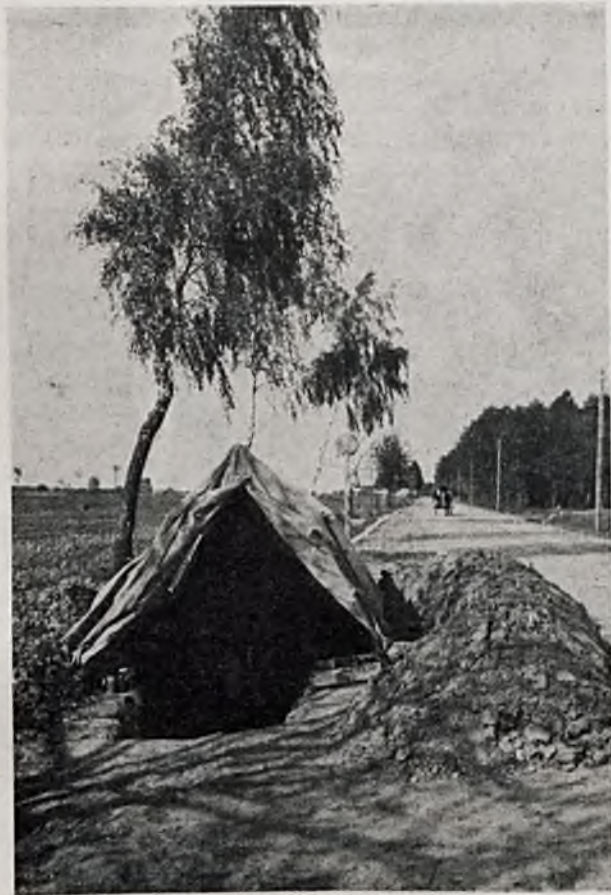
RYS. 6. WŁĄCZANIE SKRZYNI CEWKOWEJ NA ODCINKU PIOTRKÓW — CZĘSTOCHOWA.
