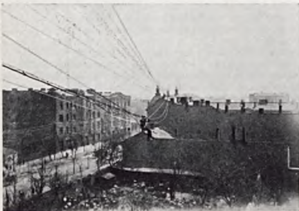
RYC. 1. ROBOTNIK UMIESZCZONY W KOSZU PRZEWIESZA KABEL ZE STAREJ LINKI NA NOWĄ.
