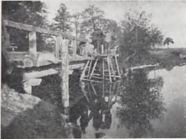
RYŚ. 5. WBIJANIE PALI KAFAREM RĘCZNYM.
