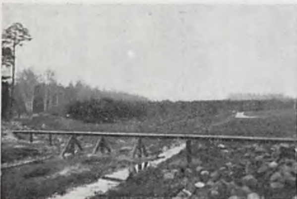
RYŚ. 6. PRZEPROWADZENIE KABLA NAD POTOKIEM W ŁĄGIEWNIKACH.
