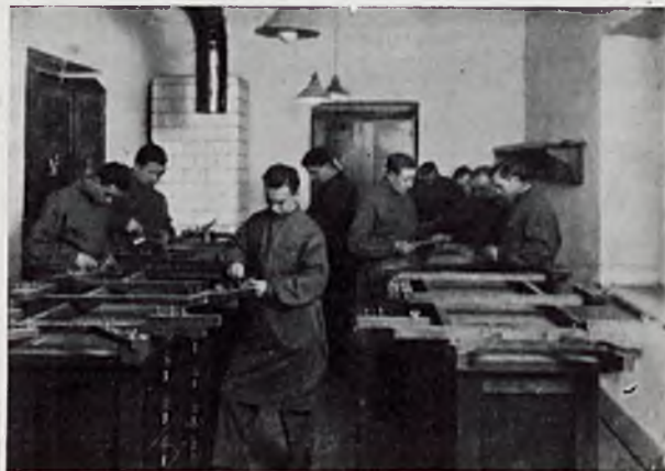
RYC. 12. WARSZTATY. SALA DO ROBÓT KABLOWYCH.
