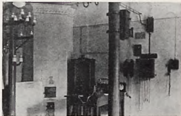
RYS. 5. ĆWICZEBNA STACJA TELEGRAFICZNO-TELEFONICZNA NR. 2, SEŁP LINJOWY I STACYJNY.
