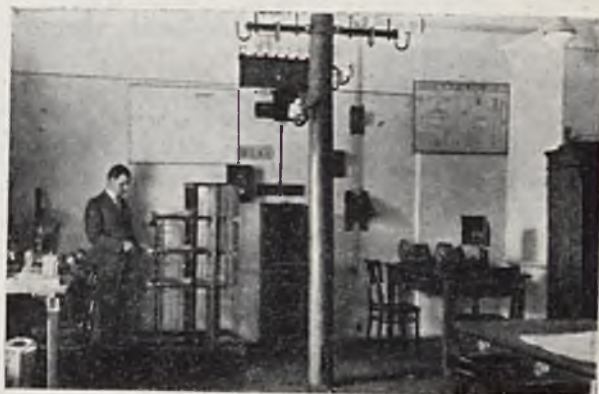
RYS. 6. ĆWICZEBNA STACJA TELEGRAFICZNO-TELEFONICZNA NR. 3, SEŁP STACYJNY. PRZEŁĄCZNICZKA TELEFONICZNA.
