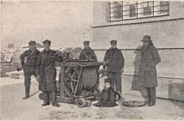
RYŚ. 3. WINDA DO WCIĄGANIA KABLI PRZY STUDNI OBOK CENTRALI TELEFONICZNEJ.
