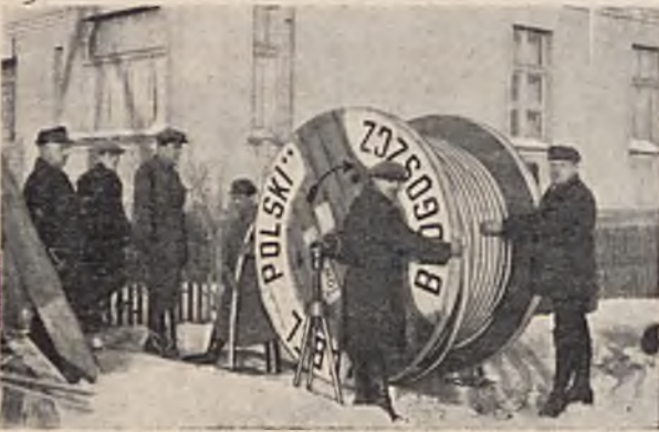
RYŚ. 4. WCIĄGANIE KABLA 600 PAROWEGO PRZY ULICY 10 LUTEGO.
