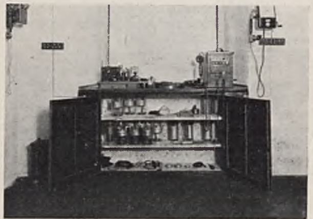
RYŚ. 4. STACJA TELEGRAFICZNA I TELEFONICZNA NR. 2.
