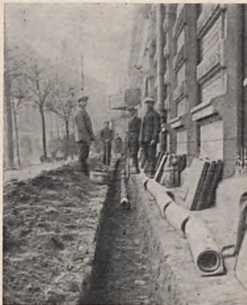
RYŚ 14. UKŁADANIE RUR JEDNOTWOROWYCH NA PLACU WOLNOŚCI WE WŁOCŁAWKU.
