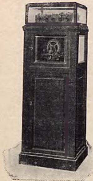
RYS. 12. WYŁĄCZNIK DZWONÓW ALARMOWYCH I TABLICZY ŚWIETLNEJ.
