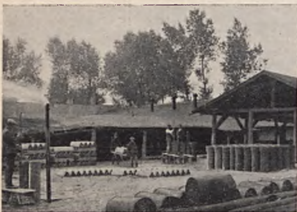
RYŚ 13. OGÓLNY WIDOK FABRYKACJI RUR CEMENTOWYCH.
