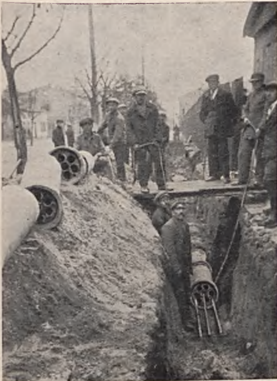
RYS. 15. UKŁADANIE RUR 7-OTWOROWYCH NA UL. WARSZAWSKIEJ WE WŁOCŁAWKU.
