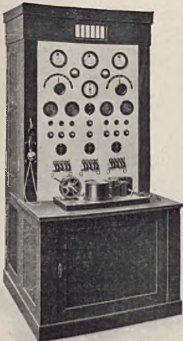
RYS. 10. CENTRALA INSTALACJI W/G SYSTEMU SIEMENSA.
