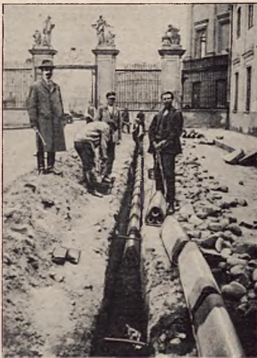
RYC. 7. UKŁADANIE RUR 3-OTWOROWYCH NA PLACU SASKIM. (PODWÓRZEC TELEGRAFU).
