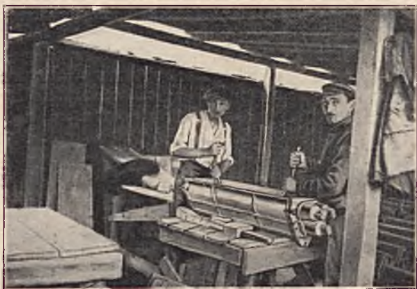
RYC. 6. WYKONYWANIE RUR 3-OTWOROWYCH.
