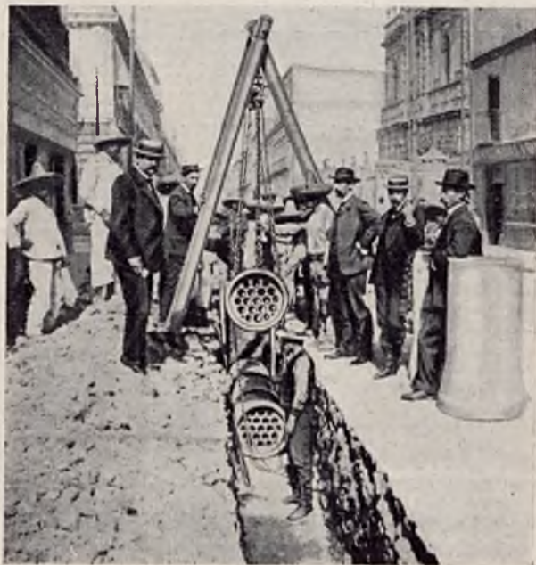
RYS. 4. UKŁADANIE BLOKÓW.
