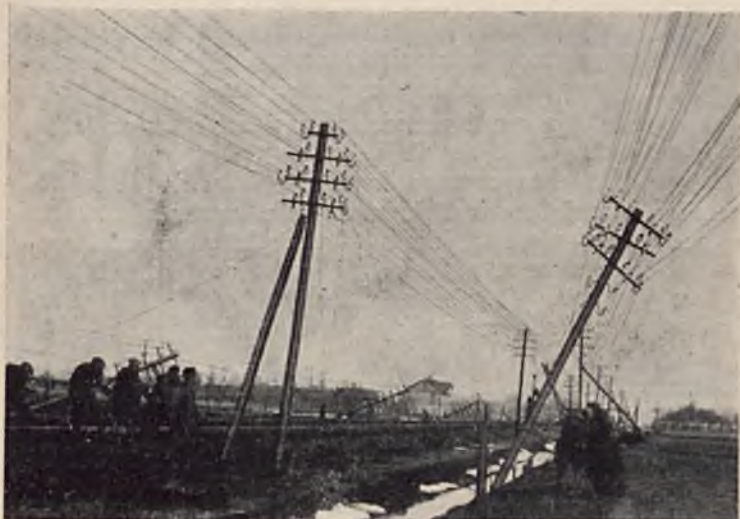
RYS. 9. PODNOSZENIE ZNISZCZONYCH TRAS POD GRODZISKIEM. POCZTOWE Z PRAWEJ STRONY, KOLEJOWE Z LEWEJ.
