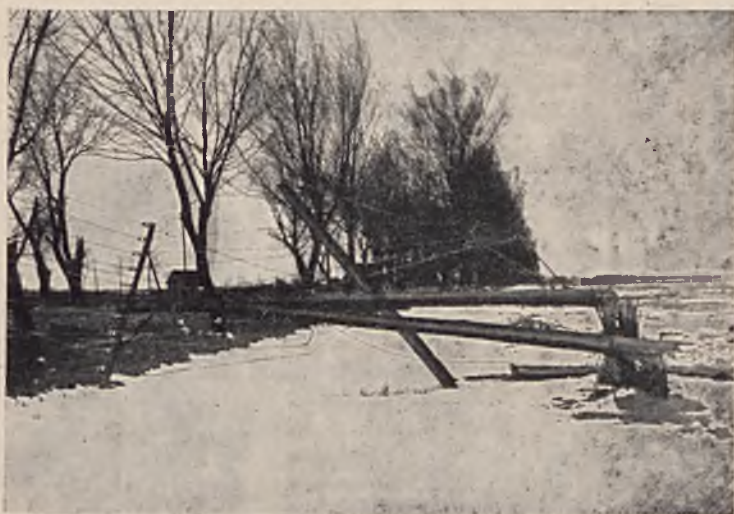
RYŚ. 1. ZŁAMANIE SŁUPA ROZKRACZNEGO NA LINII WARSZAWA—RADZYMIN.
