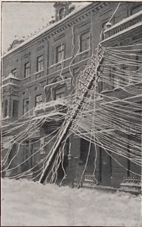
RYS. 4. ZNISZCZENIE LINJI TELEFONICZNEJ SKUTKIEM WICHURY W CZĘSTOCHOWIE.
