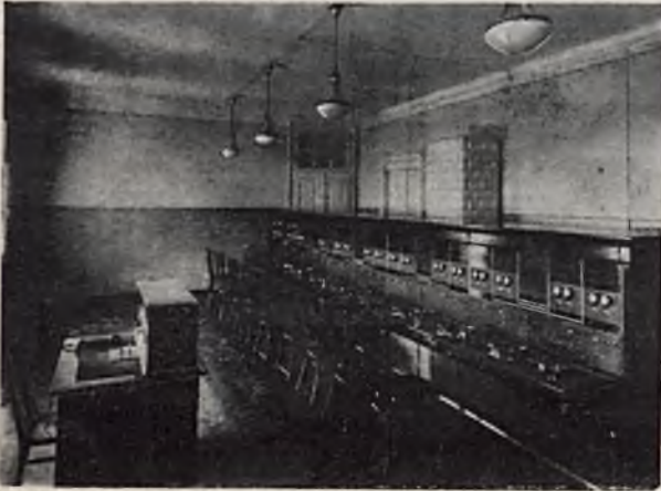
RYS. 1. STACJA MIĘDZYMIASTOWA W LUBLINIE
