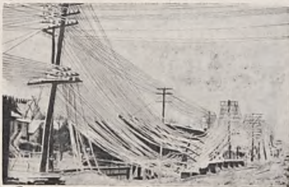
RYS. 3. ZNISZCZENIE LINJI TELEFONICZNEJ PRZEZ GOŁOLEDŹ.
