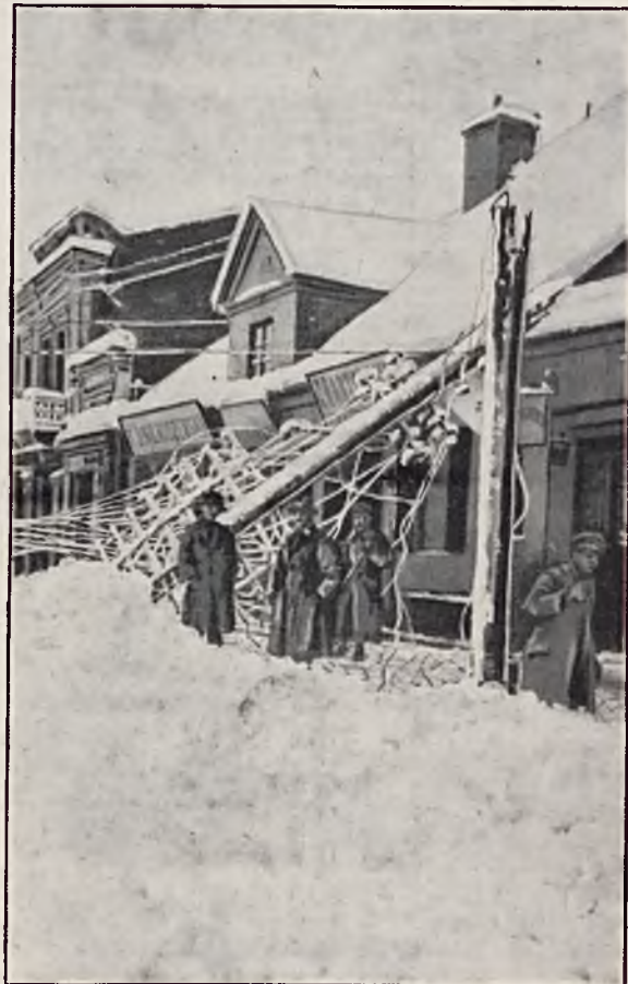
RYŚ. 2. ZNISZCZENIE SIĘCI TELEFONICZNEJ W CZĘSTOCHOWIE.
