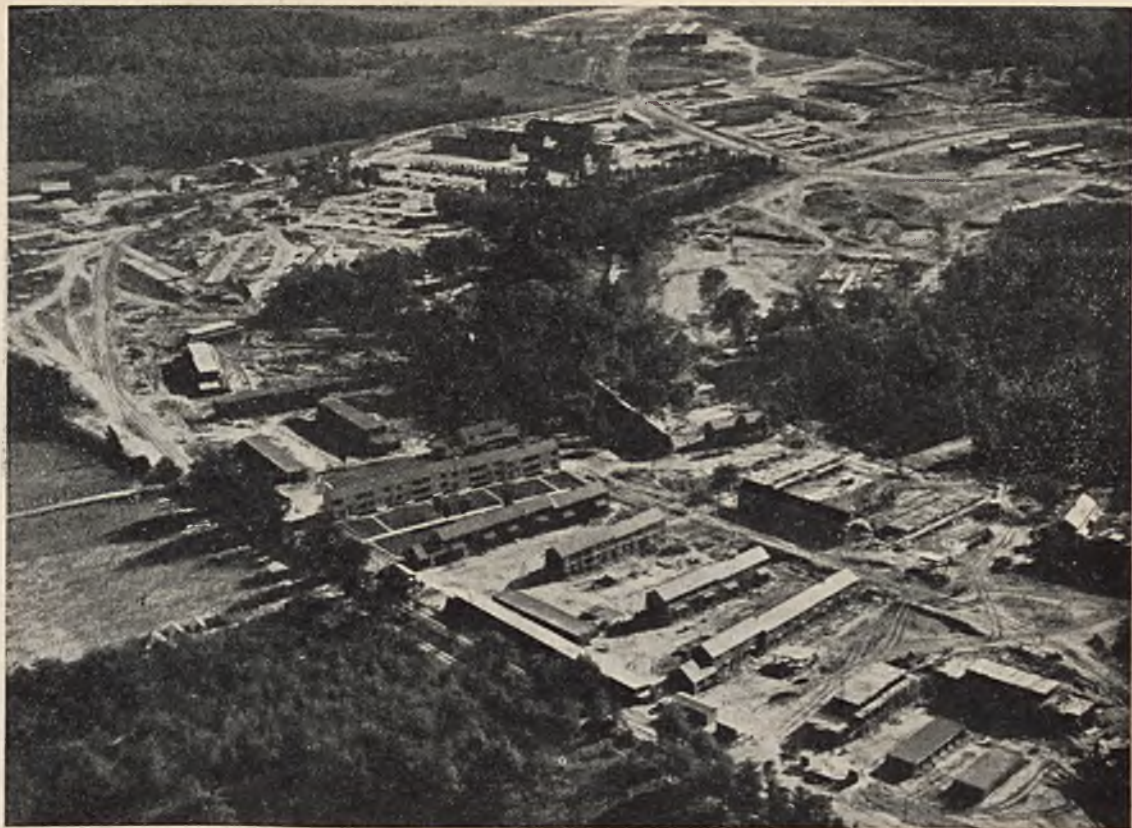
Rys. 521. Osiedle Greenbelt w budowie. Widok z lotu ptaka.
