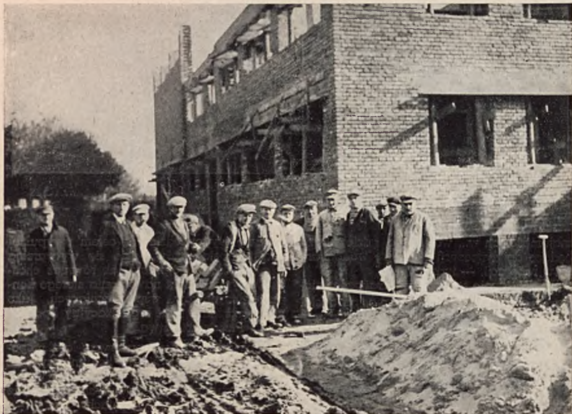
Rys. 459. Spółdzielnia „Murarz”. Budowa domu społecznego na Rakowcu.
