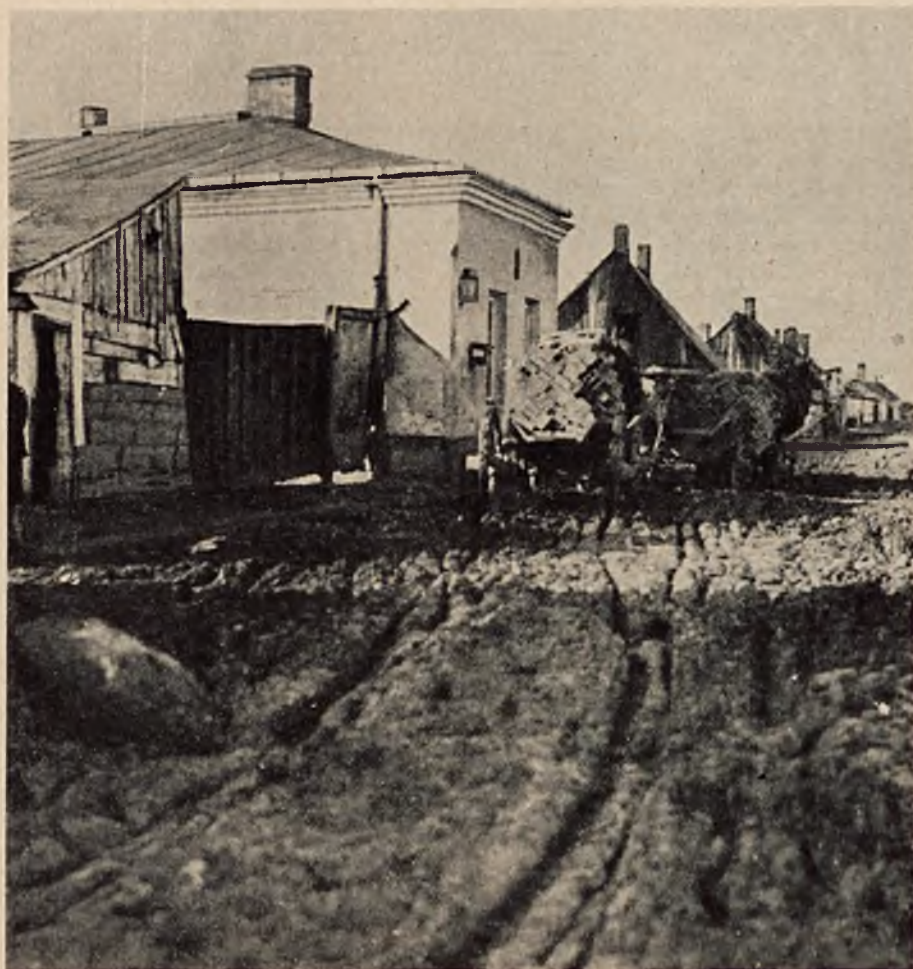
Rys. 417. Stan urządzenia ulicy Pruszkowskiej w r. 1934.
