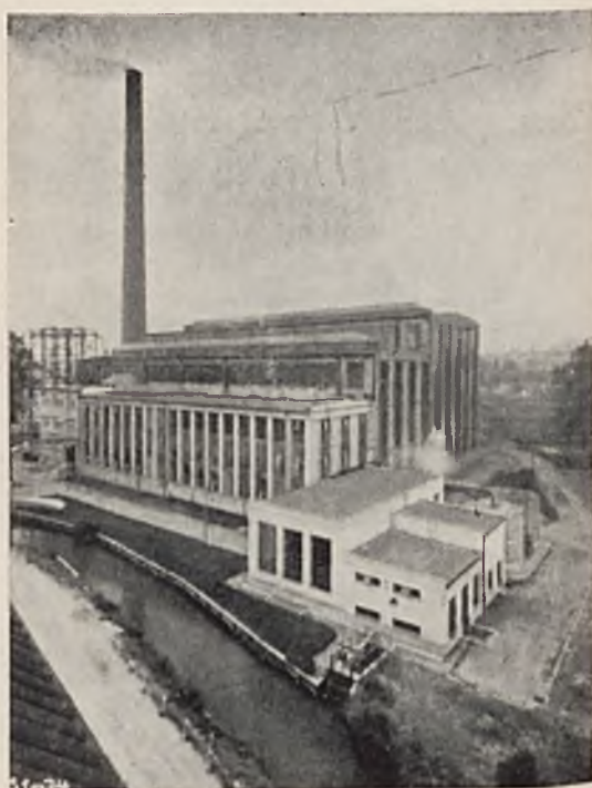
Rys. 325. Centrala ciepłno-elektryczna w Brnie, w Czechosłowacji.
