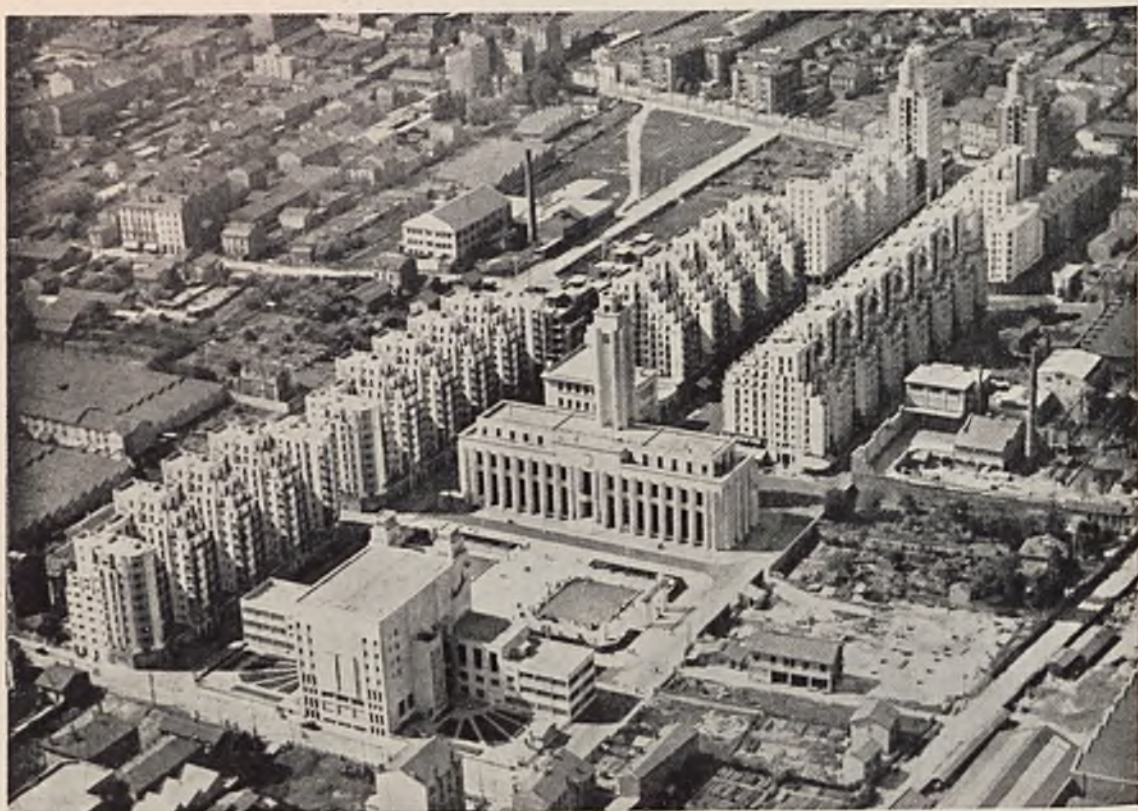
Rys. 323. Osiedle Villeurbanne pod Ljonem, ogrzewane jedną centralą cieplną, zaopatrującą jednocześnie 30 zakładów przemysłowych.
