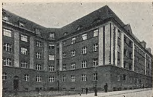
Rys. 5. Dom Spółdzielni Budowlanej Polskich Urzędników Państwowych w Poznaniu z r. 1926.
