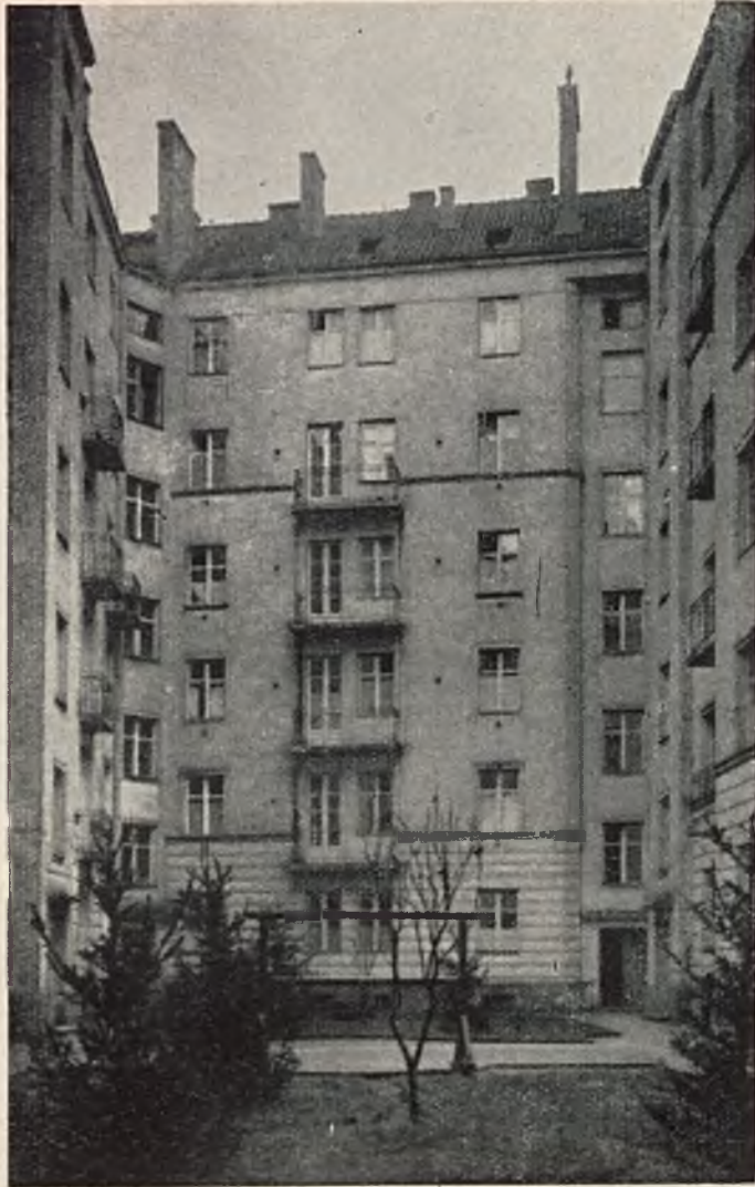
Rys. 2. Dom „spółdzielczy” o ciasnym podwórzu-studni, nie różniący się sposobem zabudowy od zwykłej kamienicy czynszowej.
