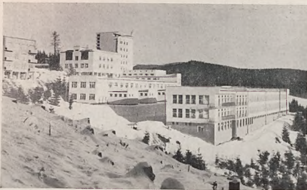
Rys. 100. Sanatorium w Istebnej. Projekt arch. Łoboda i Dobrzyńska. Elewacje (ca 14.000 m. 2 ) wykonane całkowicie „Felzytynem” W (wodoodpornym) w kolorze białym i „Skalenicie” czarnym. Dachy i tarasy izolowane „Trocalem”.
