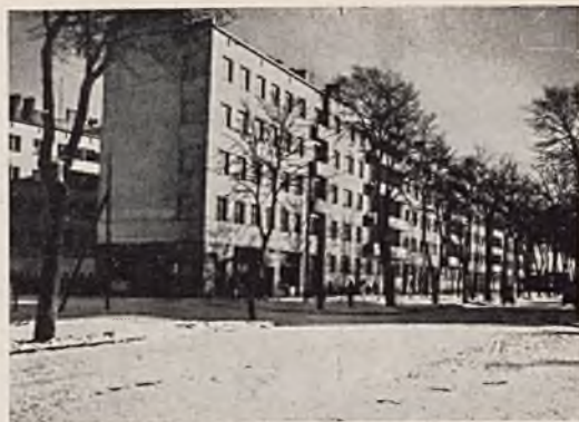
Rys. 69. Dom mieszkalny Z. U. S. w Gdyni przy ul. Śląskiej.
