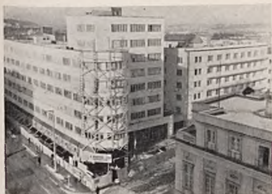
Rys. 72. Dom biurowo-mieszkalny Z. U. S. przy ul. 10 lutego.
