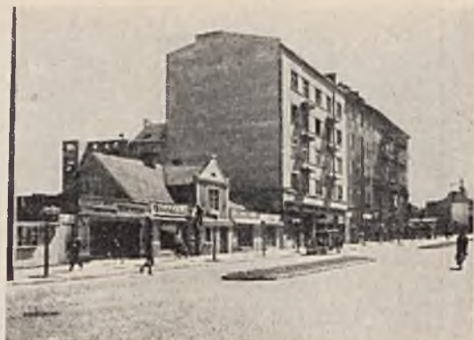
Rys. 71. Kontrasty — zabudowa głównej ulicy (Świętojańskiej) w Gdyni.
