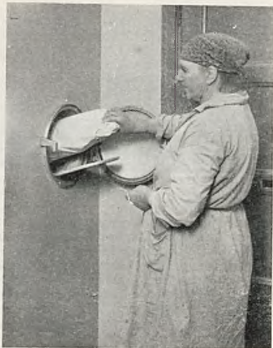
Rys. 328. Wewnętrzny kanał na śmieci w osiedlu mieszkalnym szwedzkim. Otwory do wrzucania śmieci zamykane podwójnymi klapami.
