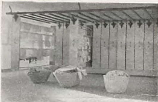
Rys. 316. W. S. M. Susznia kulisowa w pralni centralnej.
