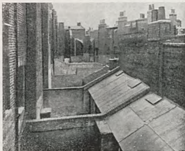
Rys. 330. Podwórza zburzonych dawnych „slums” w Marylebone, na miejscu obecnie nowozbudowanych małych mieszkań.
