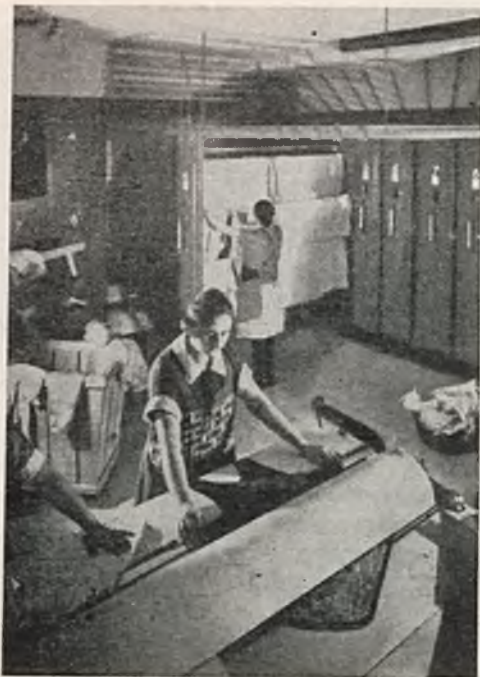
Rys. 327. Magle i suszarnia kulisowa pralni lokatorskiej w osiedlu mieszkalnym niemieckim (pg. „Wohnen u. Bauen”).
