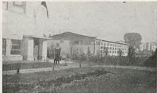
Rys. 319. Przedszkole w Osiedlu W. S. M.
