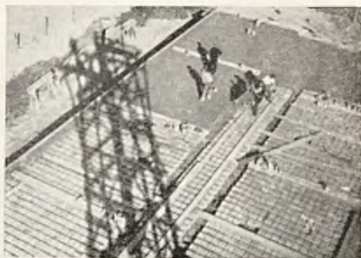
Rys. 353. Fragment budowy mieszkań T. O. R. na Kole. Zdjęcie z dn. 5 października 1935 r.
