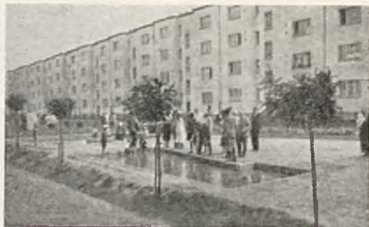
Rys. 321. Brodzianka na dziedzińcu IV. Kolonii W. S. M.
