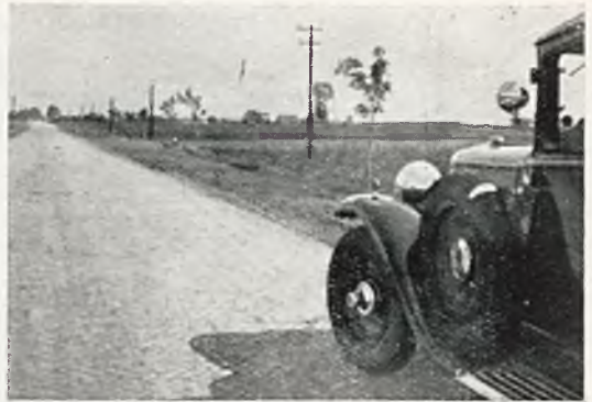
Rys. 221 i 222. Z drogi Warszawa — Poznań. Racjonalne utrzymanie zabudowań w pewnej odległości od drogi i obsłużenie ich osobną równoległą lokalną drogą — ulicą.
