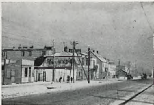
Rys. 219 i 220. Drogi wyjazdowe z Warszawy. Gęste obudowanie tuż przy jezdni stwarza stałe wzajemne przeszkadzanie ruchu lokalnego i dalekobieżnego.
