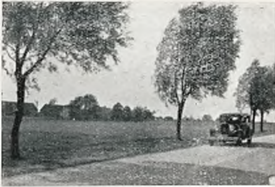
Rys. 221 i 222. Z drogi Warszawa — Poznań. Racjonalne utrzymanie zabudowań w pewnej odległości od drogi i obsłużenie ich osobną równoległą lokalną drogą — ulicą.
