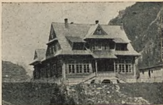
Rys. 100. Schronisko przy Morskiem Oku; pierwsze piętro schowano w dachu, zaczerpniętym z nieposiadającej piętra chaty góralskiej; skutkiem tego ze wszystkich pokoi sypialnych tylko j e d e n posiada okna, oświetlające pokój w sposób dostateczny
