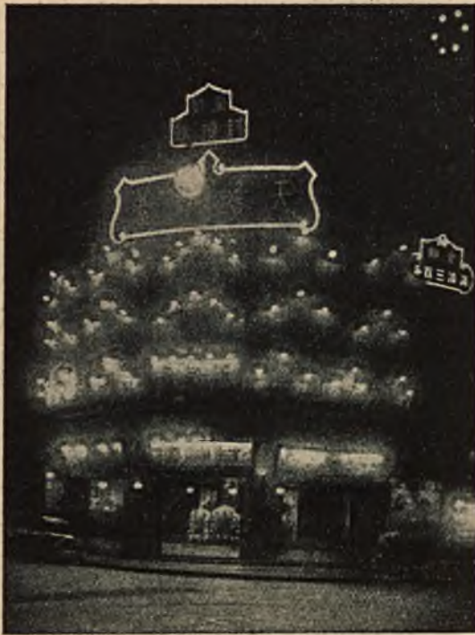
Rys. 69. Szanghaj. Oświetlenie reklamowe teatru (dolna część żarówki, góra rury neonowe) (podł. Deutsche Bauzeitung).
