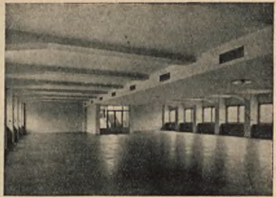
Rys. 86. Wnętrze hali biurowej.
