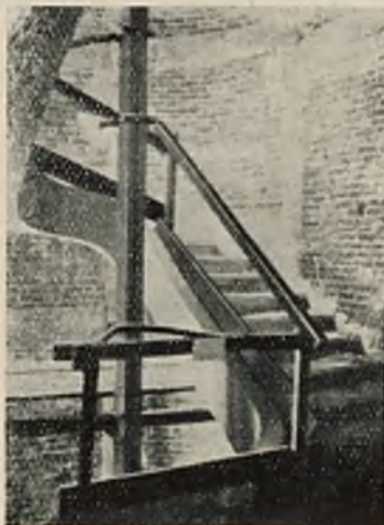
Rys. 55. Zabezpieczenie schodów na budowie.
