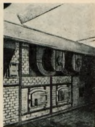
Rys. 7. Paleniska na pył węglowy Ściana przednia z palnikami
