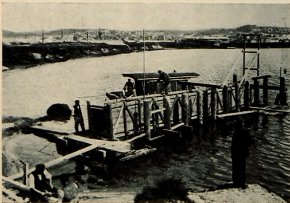
Rys. 19. Zapuszczanie rury drewnianej do morza.
