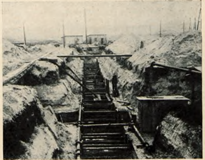
Rys. 10. Budowa kanału wody morskiej; z przodu studnia rozgałęźna wody zimnej i ciepłej.
