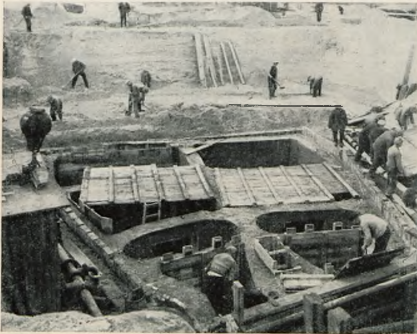
Rys. 14. Fundamenty budynku pomp i sił.
