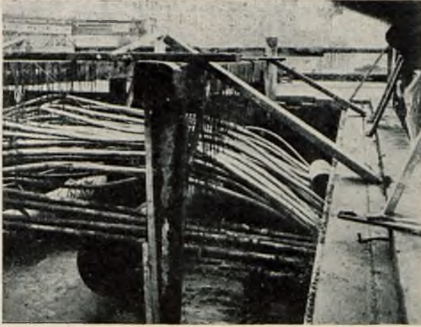
Rys. 14. New York, uliczna sieć kabli podczas przebudowy ulicy.
