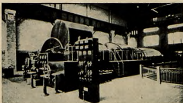
Rys. 8. Turbozespół 80 MW, 1800 obr. w elektrowni Port Washington.
