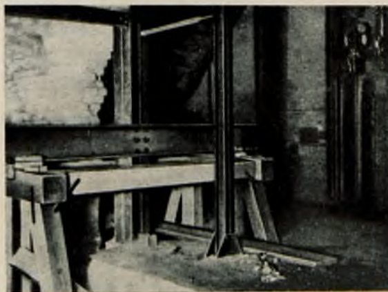
Rys. 2. Paleniska na pył węglowy. Uchwycenie bocznych podpór kotłów.
