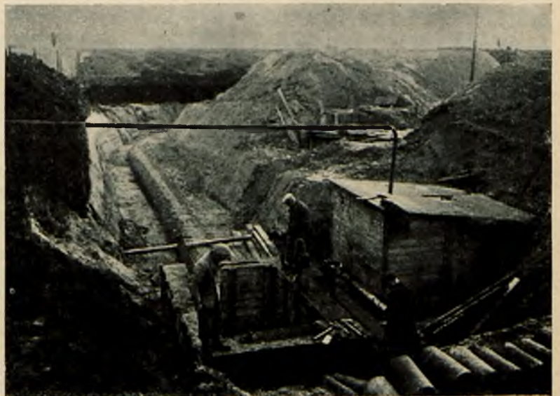
Rys. 12. Odpływ wody ciepłej kanałem obejściowym przy bud. elektr.
