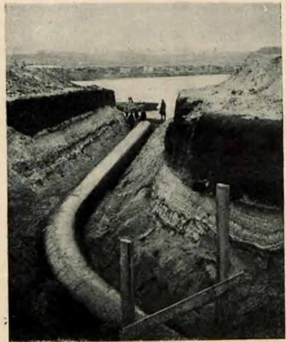
Rys. 11. Układanie kanału wody ciepłej.
