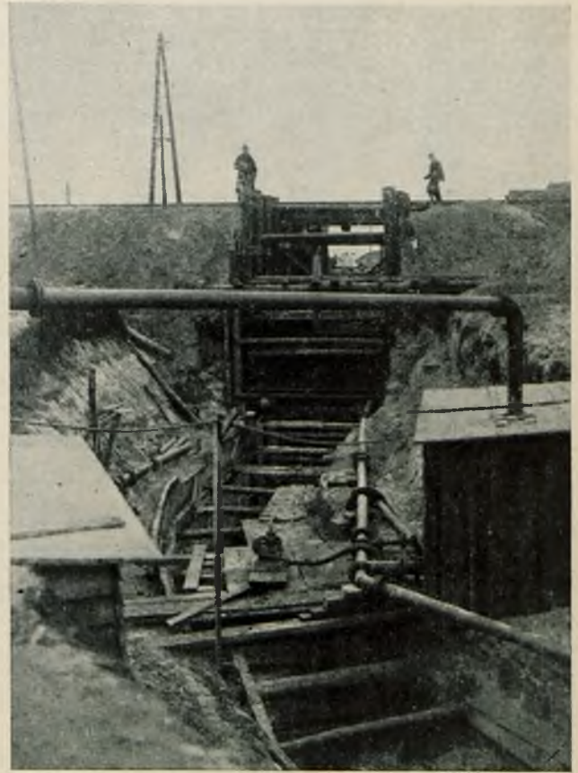
Rys. 17. Przekroczenie bocznicy kolejowej. Wykop.
