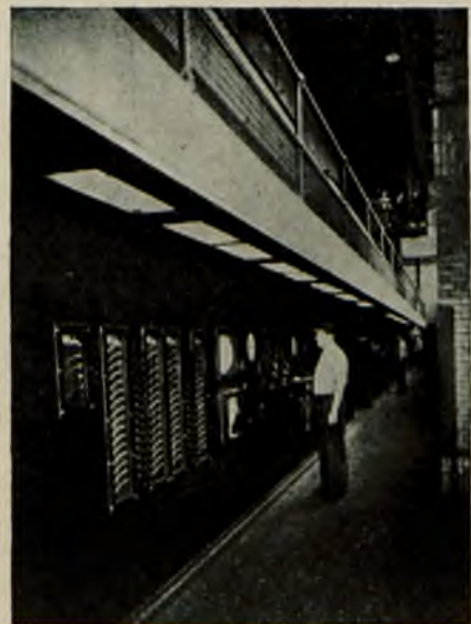
Rys. 17. Nastawnia w kotłowni Hudson Avenue.
