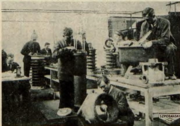
Fot. 4. Montaż części aktywnej wyłącznika 150 000 V
