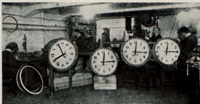
Rys. 15. Montaż zegarów elektrycznych w krajowych zakładach f-my Ericsson.
