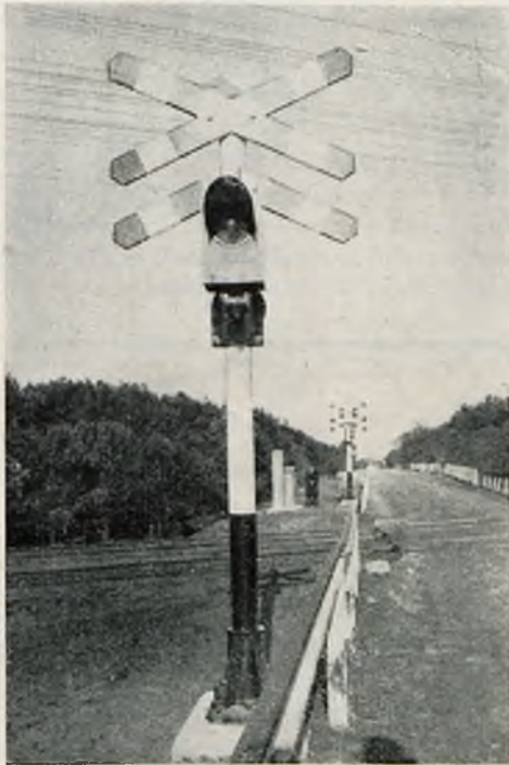
Rys. 16. Sygnalizacja na przejeździe kolejowym.
