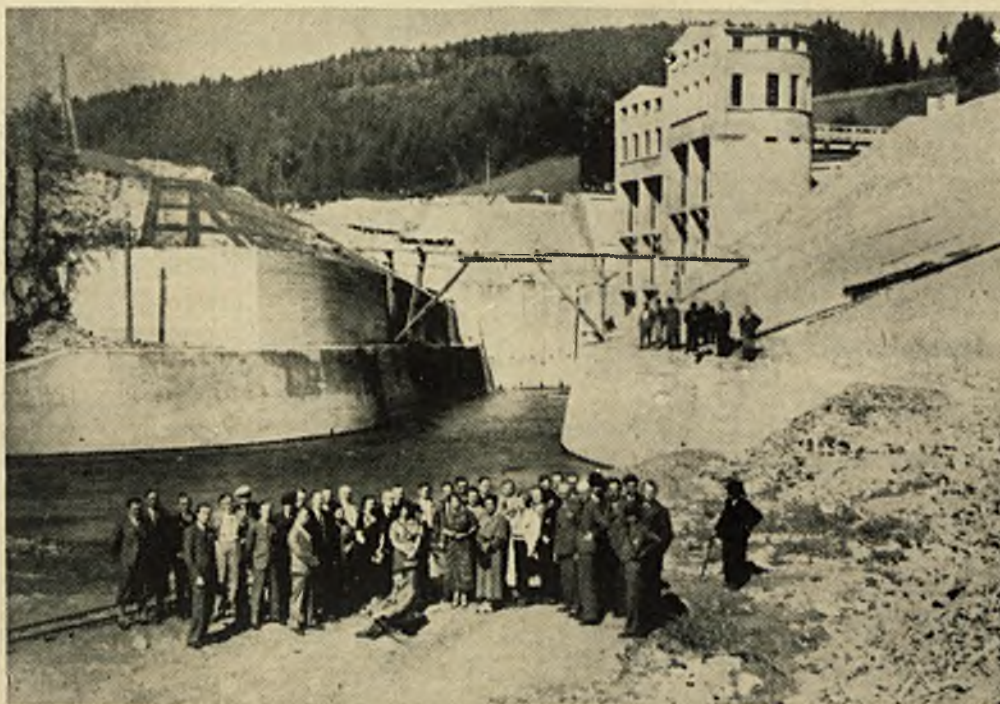
Wycieczka S. E. P. przy budującej się zaporze wodnej w Porąbce na rzece Sole.
