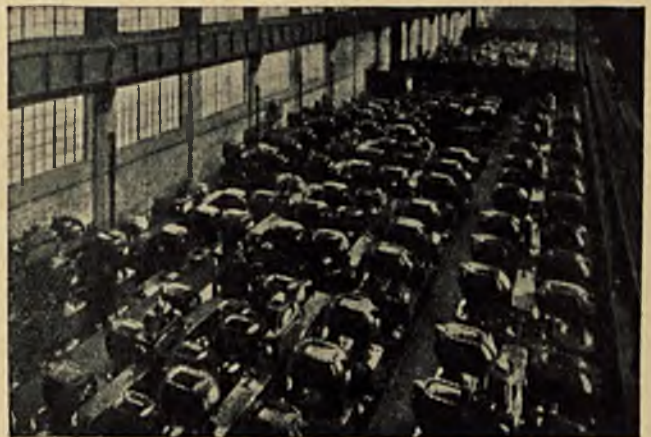
Rys. 4. Okapturzona rozdzielnia 66 kV.
