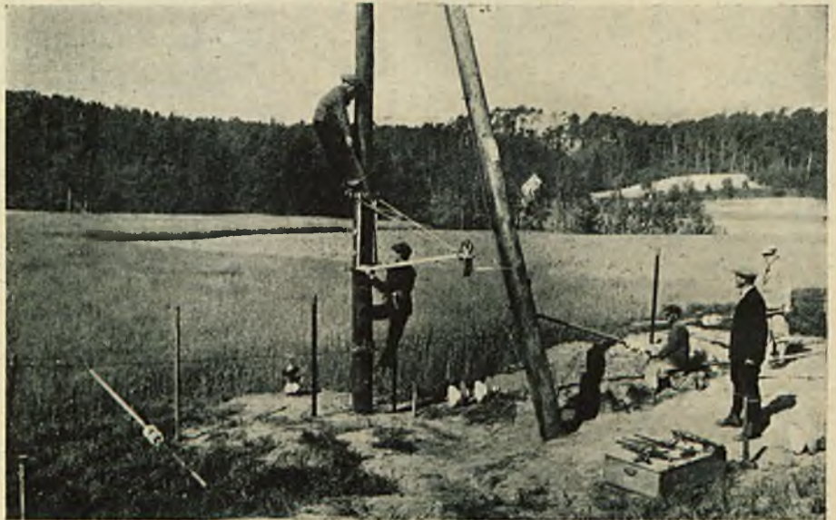
Rys. 3. Whaczenie przewodu w żłobek z izolatorami.
