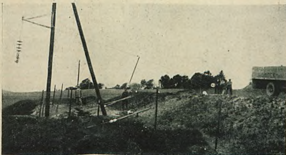
Rys. 4. Podciąganie przewodu po zdjęciu uziemienia.
