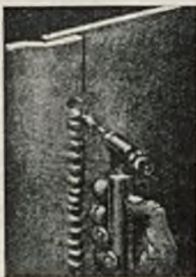
Rys. 5. Spawanie pionowe ołowiu.
