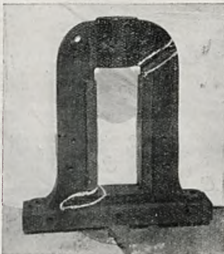
Rys. 10. Rama po zukosowaniu pęknięć.
