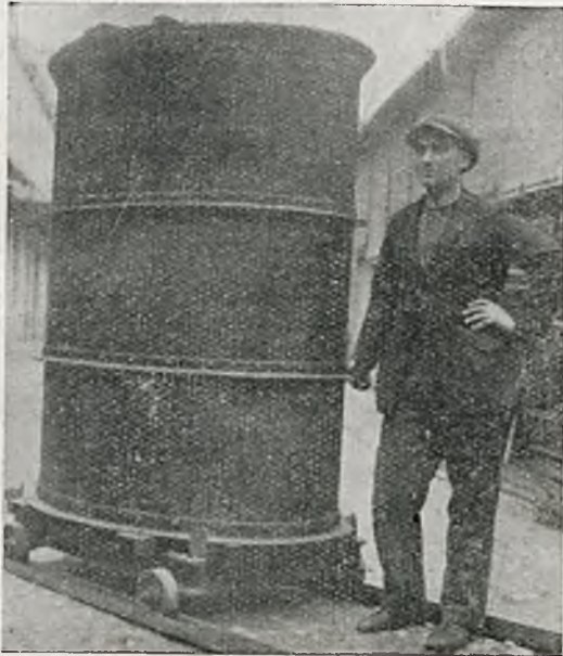
Rys. 1. Transformator nitowany.
