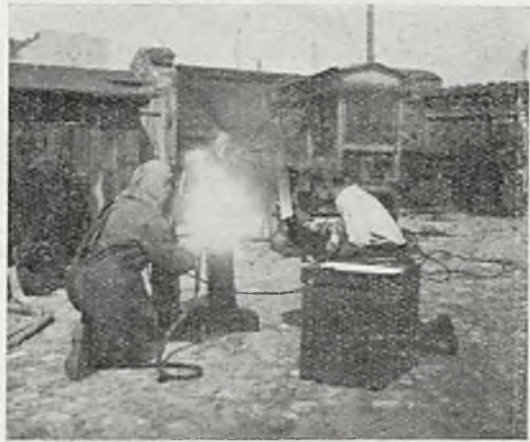
Rys. 11. Spawanie ramy z rys. 10.
