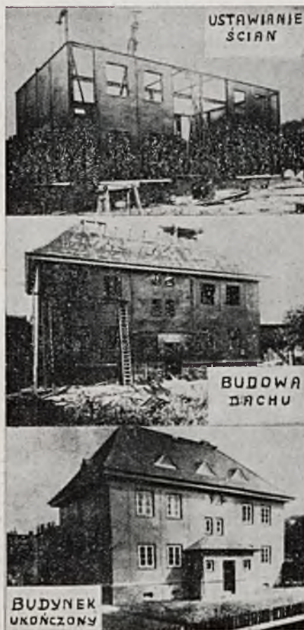
Rys. 3. Typ domku całkowicie żelaznego w niektórych swoich stadiach budowy.
