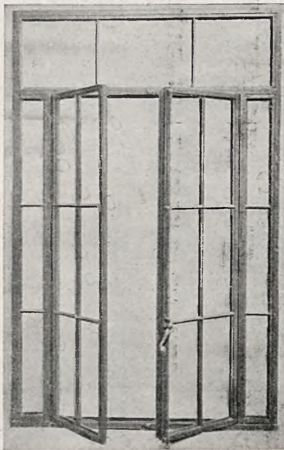
Rys. 5. Okno żelazne spawane.
