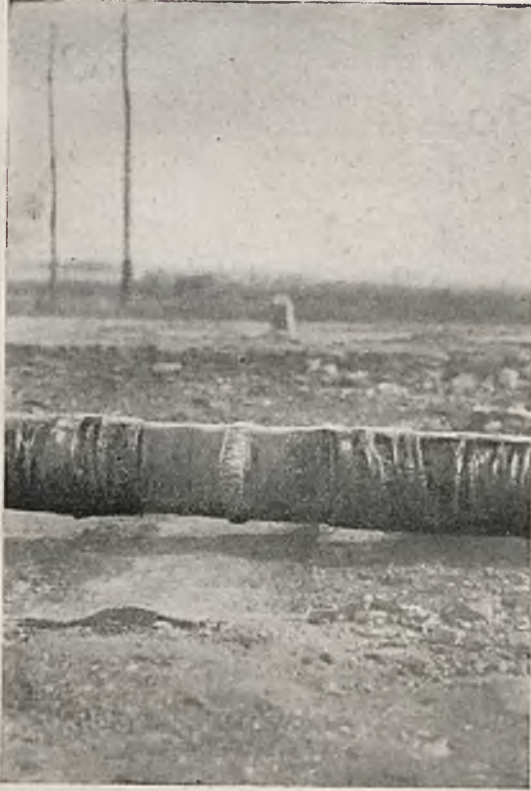
Rys. 13. Spoina przed założeniem warstwy smoły.
