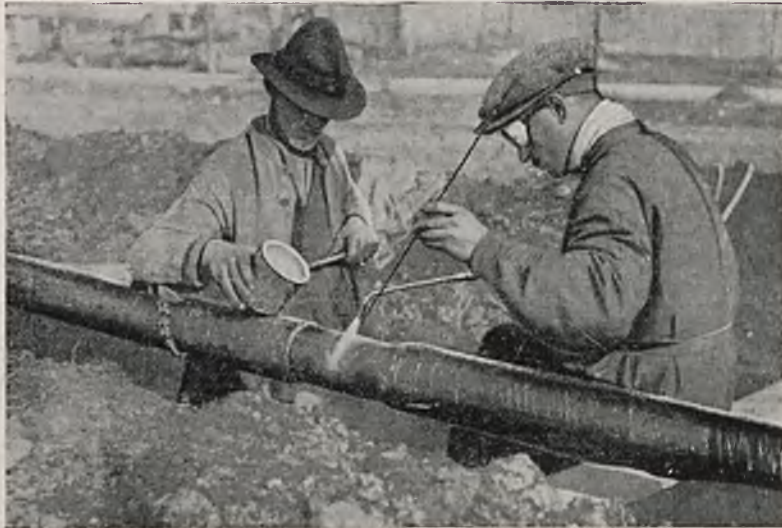
Rys. 11. Spawanie dłuższych odcinków nad rowem.
