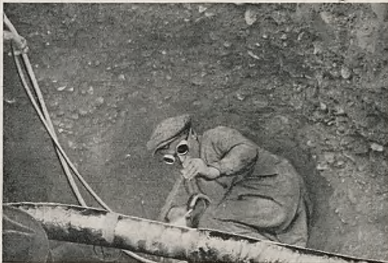
Rys. 2. Wykonanie spoiny łączącej spawane rury.
