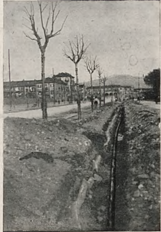
Rys. 15. Przewód ułożony w rowie.
