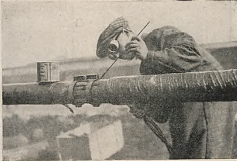
Rys. 9. Zczepianie dwóch odcinków rur.
