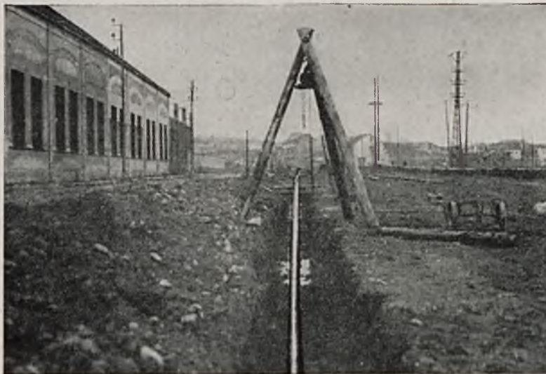
Rys. 12. Układanie rurociągu w rowie.
