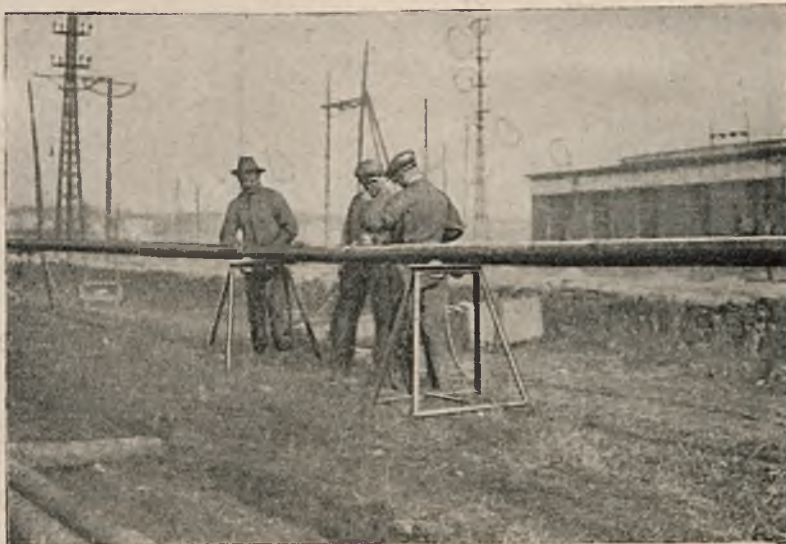
Rys. 10. Spawanie rur na kozłach.
