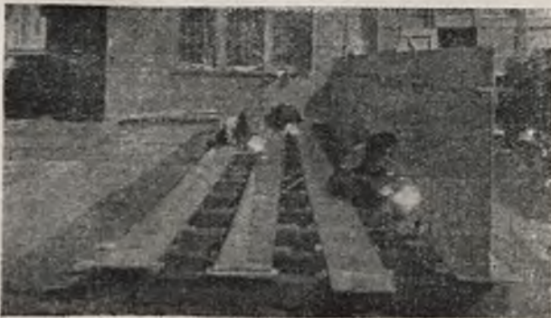
Rys. 2. Belka główna, wykonywana w warsztacie.
