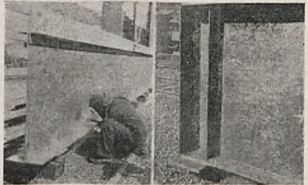
Rys. 3. Szczegóły wykonania belek zapomocą spawania.
