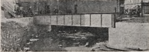
Rys. 1. Ogólny widok mostu.
